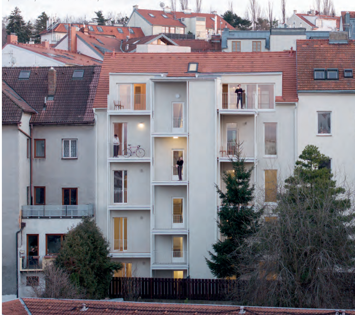
Dům ve Šlikově ulici na pražském Břevnově. Úprava zadní části domu pomohla vytvořit terasu u každého bytu.
